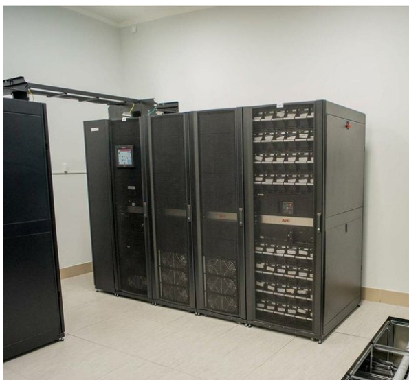
Модульный ИБП Symmetra PX 500
